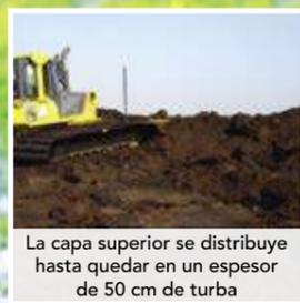
La capa superior se distribuye hasta quedar en un espesor de 50 cm de turba
